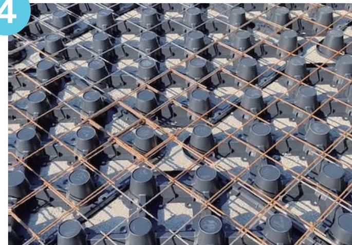
ワイヤーメッシュをガイドの印に合わせてスポツと置きます。スペーサー不要。ガイドに沿って並べるだけで簡単にコンクリート強度を高めます。
