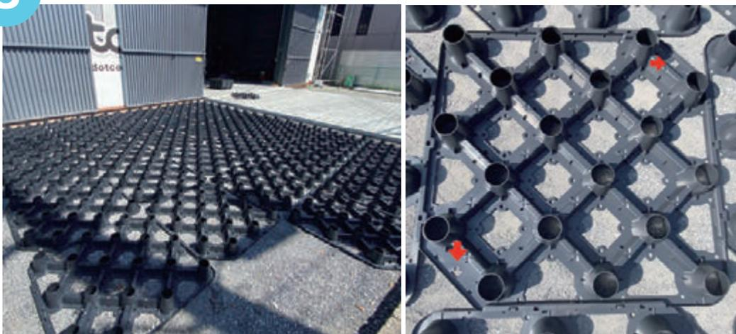
施工箇所の形状に合わせて、パズルのように連結させた Dotcon を敷き並べます。矢印のガイドがついています。
